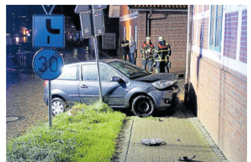
Demoliert steht der Ford Fiesta auf dem Bürgersteig an der Lüne-Brücke in Steinkirchen, Hauswand und Schild wurden beschädigt. Foto: Brandt
